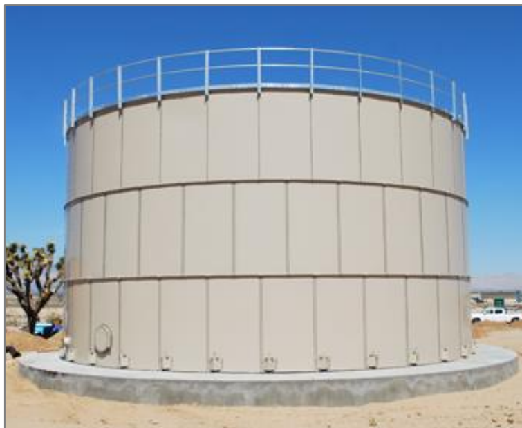
Figura 6: Tanque de almacenamiento empernado [9]
